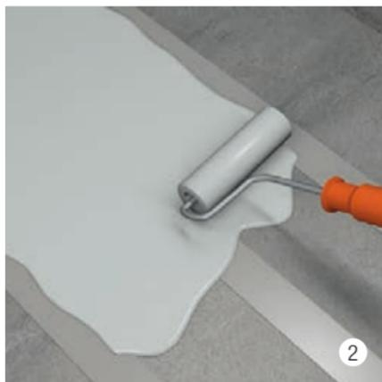
Applicare BIKUCOAT-SMP ECO sopra il primo strato, consumo di ca. 1,5–2,0 kg/m<sup>2</sup>.
