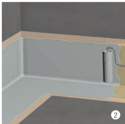
Applicare BIKUCOAT-SMP ECO sopra il primo strato (ca. 1,5–2,0 kg/m<sup>2</sup>).
